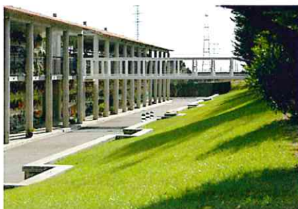
Les noves passeres del Cementiri uneixen els blocs de nínxols de dos pisos d'alçada.
