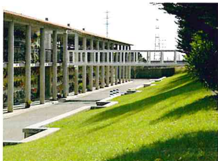
Los nuevos puentes pasadizos del Cementerio unen los bloques de nichos de dos pisos de altura.
