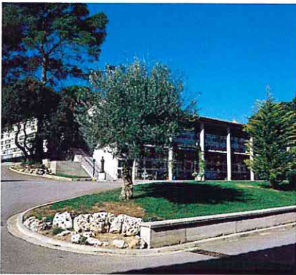
Asfaltatge de les vies més importants
