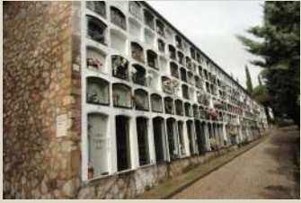
Rehabilitació dels blocs de nínxols
