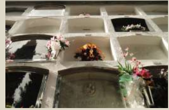
Rehabilitació dels blocs de nínxols
