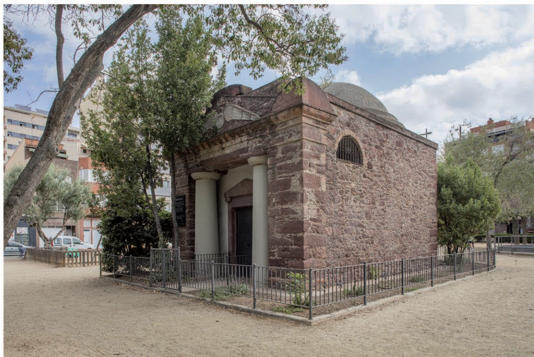
Capella del Cementiri de Vallparadís. Un dels pocs elements que queden in situ , ara plaça de Joan Miró.
