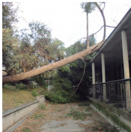
A l'interior del cementiri es van comptabilitzar 120 arbres caiguts, trencats o poc estables.
